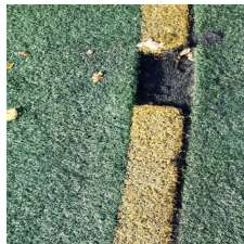
Ausrisse ganzer Belag-Segmente
