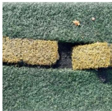
Ausrisse ganzer Belag-Segmente
