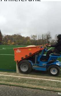
Sand wird eingebracht
